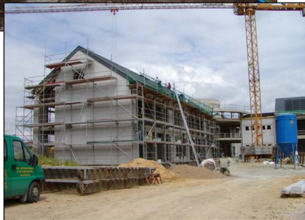
Nouvelle école à Beaufort
